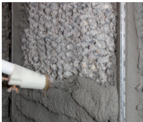
Aplicación de Mapegrout 430 lanzado
