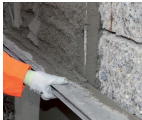
Nivelación de Mapegrout 430 con perfil de aluminio de nivelación
