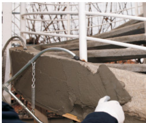
Aplicación de Mapegrout 430 con llana
