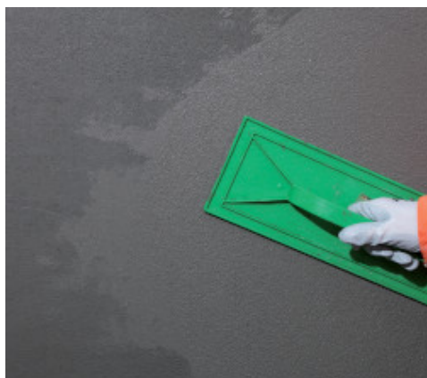
Allanado de Mapegrout 430
